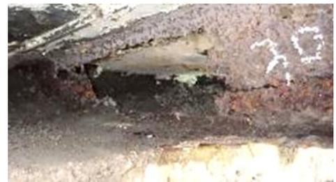
【主桁】腐食・欠損（300mm×100mm）
