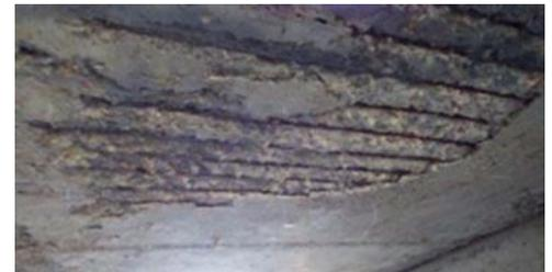
【鉄筋主桁】うき（1800mm×1800mm）
